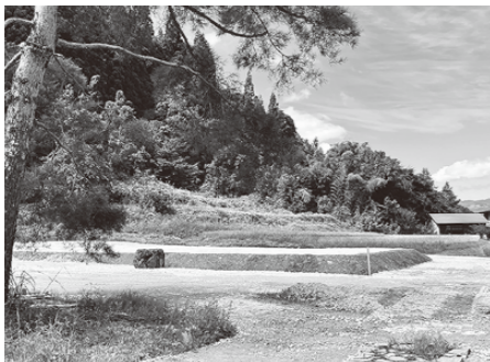
▲工事中の「安中坊別当屋敷跡」
