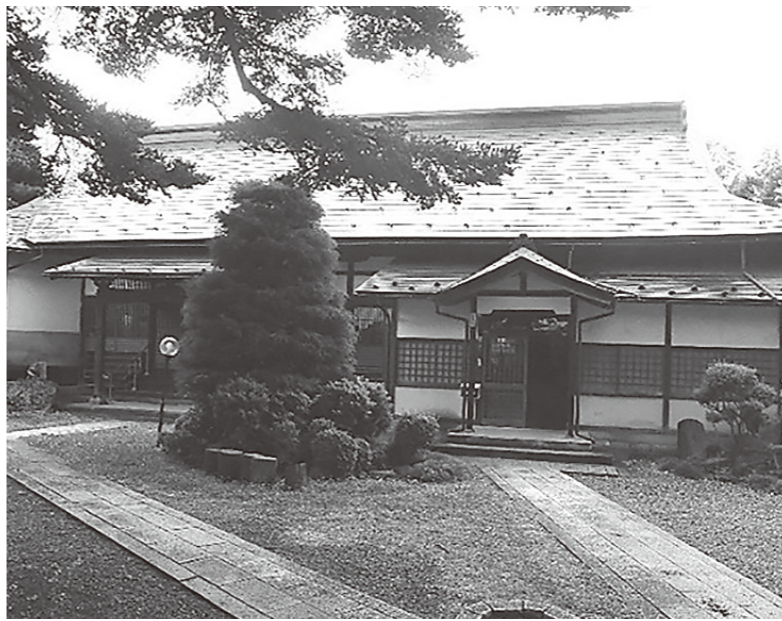
▲移設された無量寿院（山形市・常念寺）
