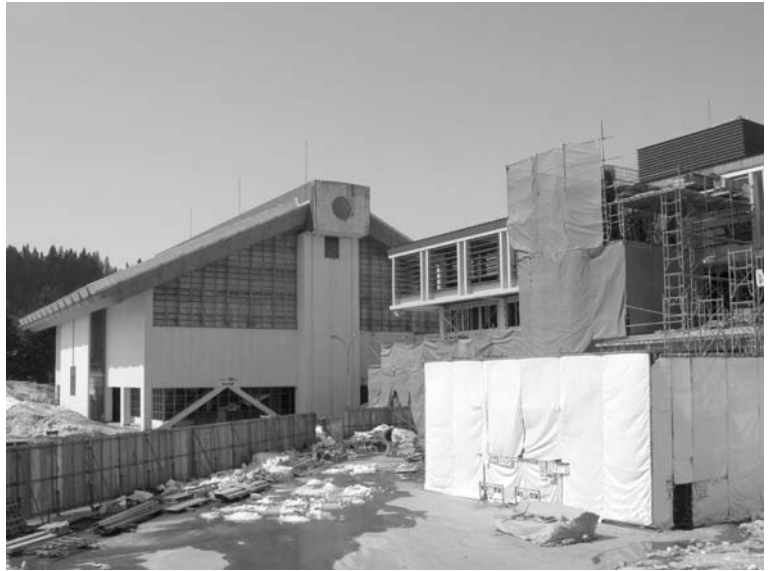
町民体育館と改修が進む開発センター
