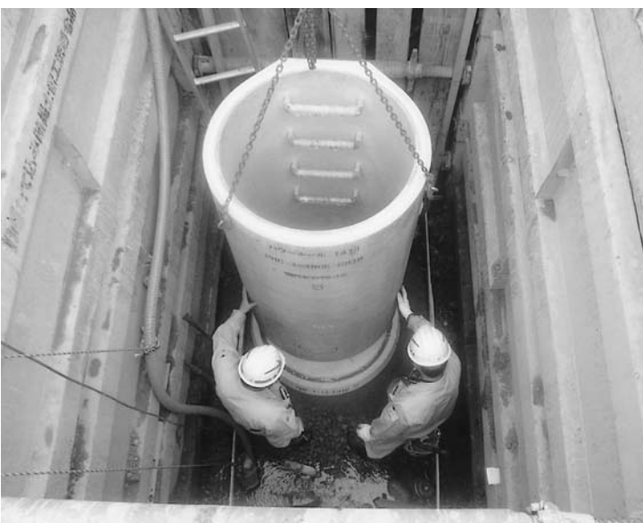
下水道管渠工事
