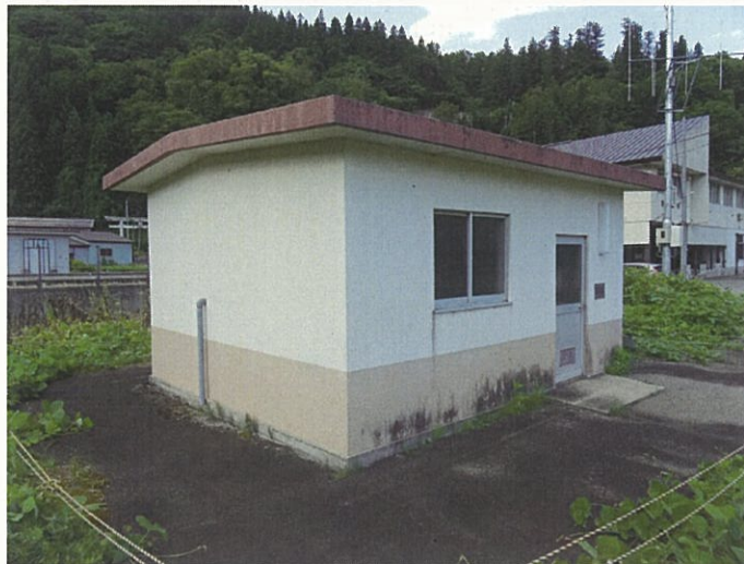
本道寺浄水場、配水ポンプ場
