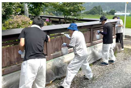
▲板塀の塗装作業
