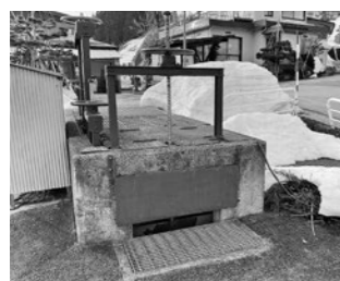
▲海味大堰水門
