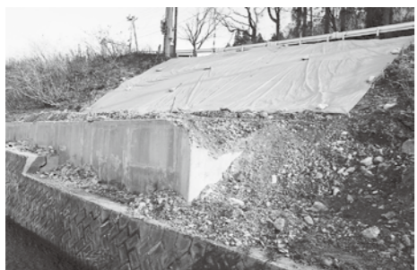
▶解体後の志津会館跡地
