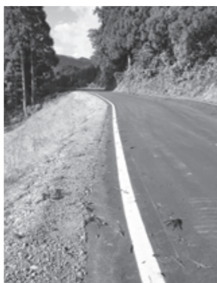
▲別の工事が出た残土を活用して工事が行われた町道桂林線
