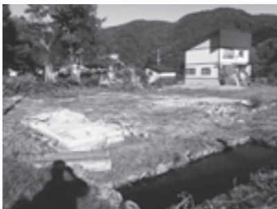
▶空き家の解体後の状況
