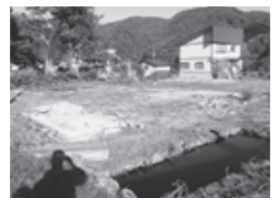
▲ 空き家の解体後の状況
