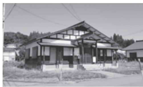
▶空き家状態の町営住宅（特定公共賃貸住宅）
