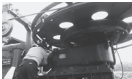
リフトの整備
