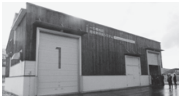
▲ 一の橋地区地域熱供給システム
