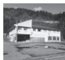
▲耐震化されていない本道寺地区集会所
