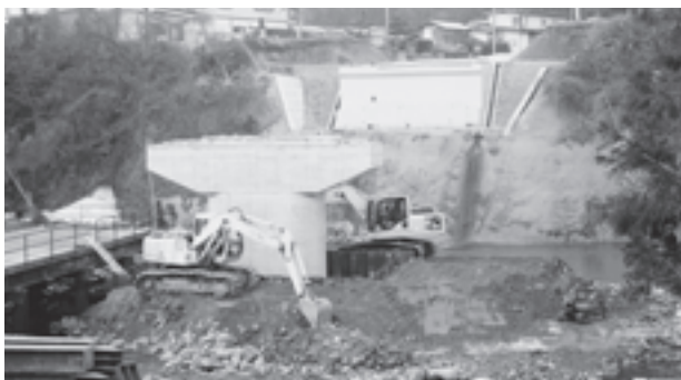
▶ 工事中のあづま橋
