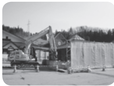
▲銘水館前の解体中のトイレ
