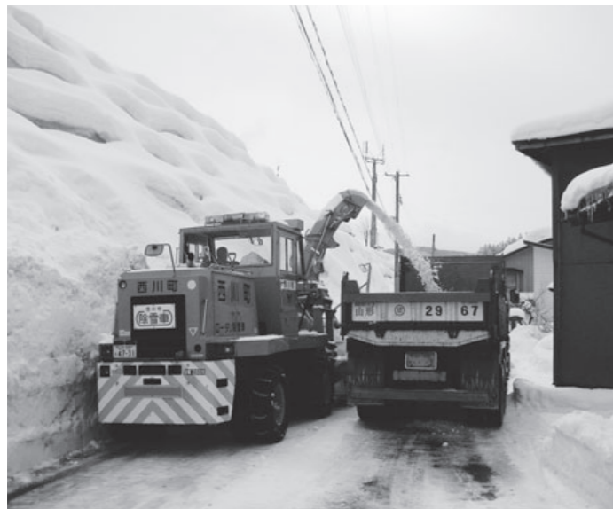
▲道路を広げるための運搬排雪
