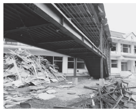
▲少子化により解体中の沼山小学校
