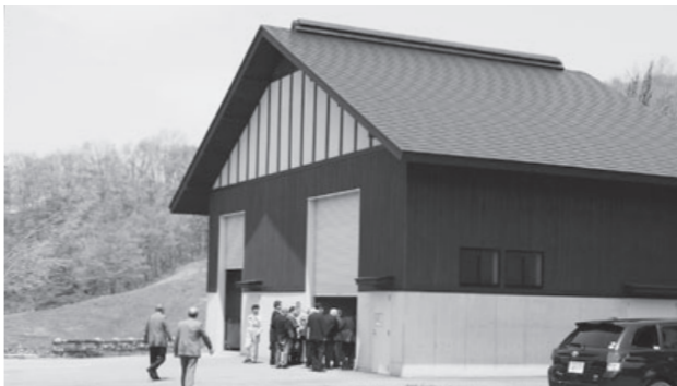
▶ 木質バイオマスボイラー棟（金山町）
