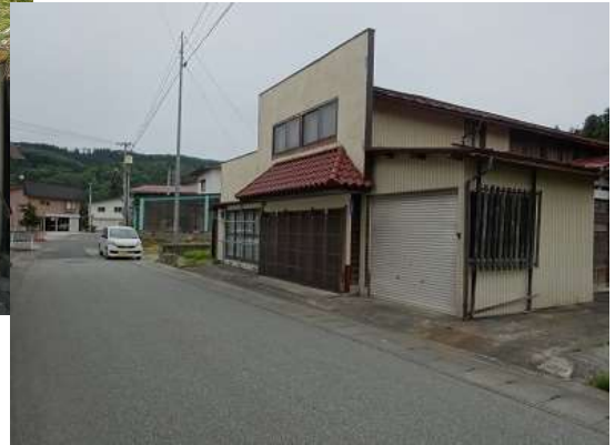
外観(南側から)
