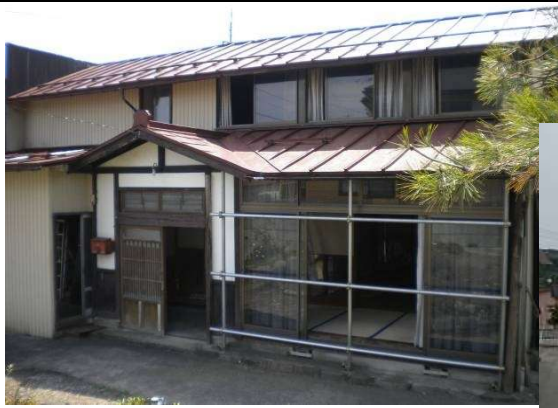
外観(東側から)
