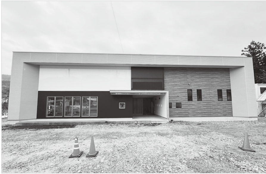
▲建設中のブレジャー対応型施設
