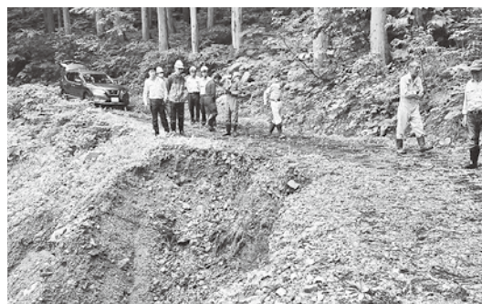
▲岩根沢の林道復旧現場
