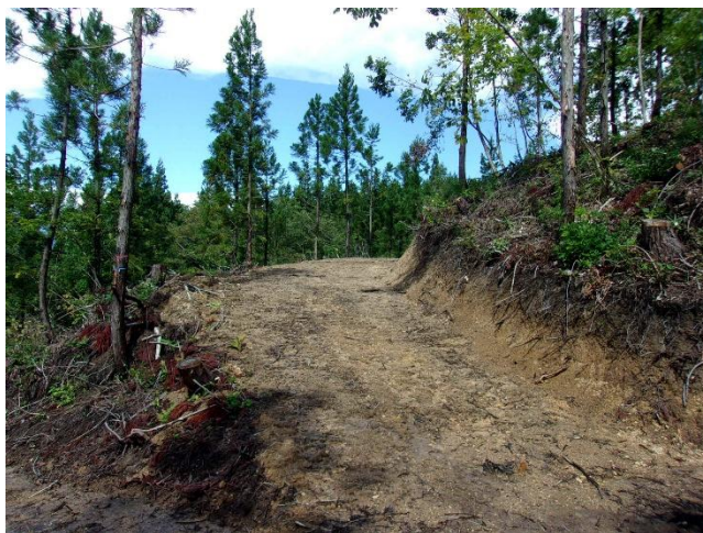
開設した作業路と A 層が薄い法面
