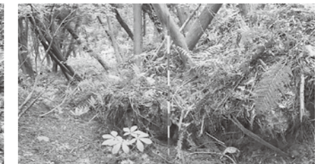
▲被害状況3 地面の盛り上がり
