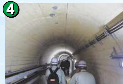
▲堤体下の監査廊ツアー
